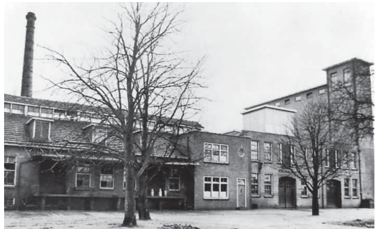
▲ De zuivelfabriek en korenmaalderij in Aalden
