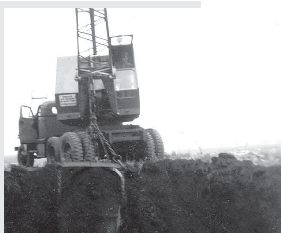
Linksboven: Geert Beugel (1959) aan het ijzeroer graven. Rechtsboven: Geert Beugel en Fake Booiman;(1958) ijzeroer graven en vervoeren met smalspoor.
