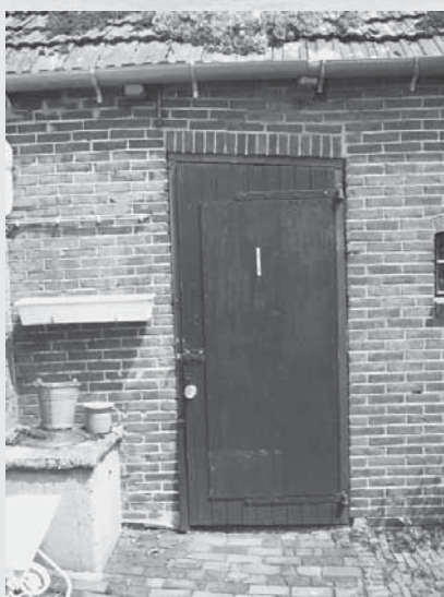
Schuurdeur met links de waterput
