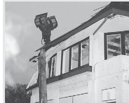
De afbraak is begonnen, oktober 2005.
