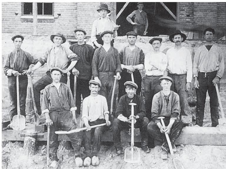
Oranje 1913; een ploeg werklui, die de dwarswijk van het Oranjekanaal naar de aardappelmeelfabriek graaft.
