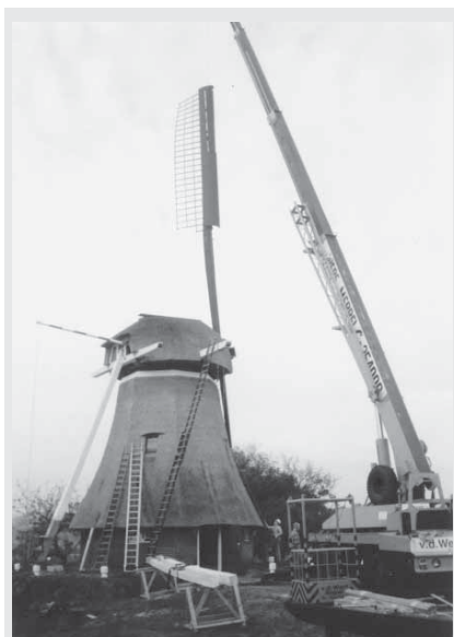
Vervolgens werden de wieken aangebracht.
