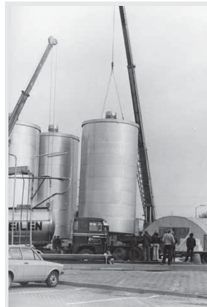
Een tank wordt geplaatst.
