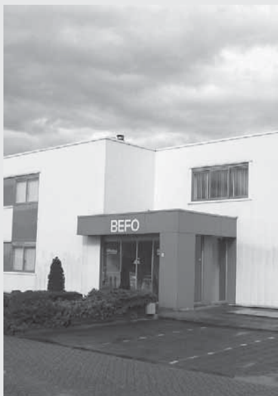
De BEFO ontwikkelcentrale aan De Zuidmaten
