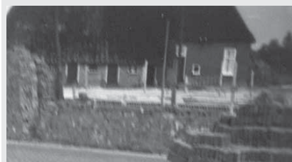
De boerderij van Harm Haan. De kerk werd gebouwd tussen de boerderij en De Drift. Er is al enig grondwerk verricht en bouwstenen staan al klaar.
