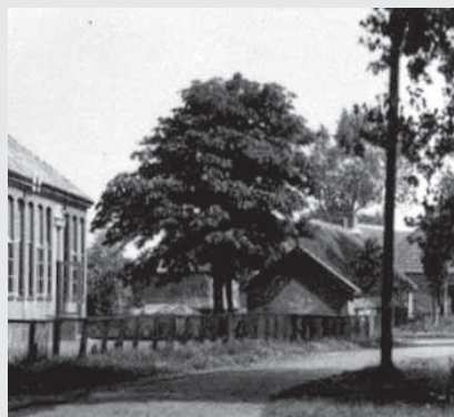
Op de foto is rechts van de school het brandspuithuisje te zien. Als je de school passeert, staat het aan de linkerkant van de weg.
