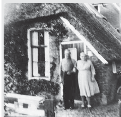
Geert Grit en zijn vrouw voor het rietgedekte huisje waar hij eerst in heeft gewoond (nr.10). Achter het rieten dak is het nieuwe huis in aanbouw te zien.
