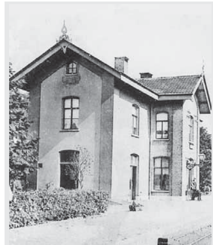
Op 1 mei 1870 werd de spoorbaan Meppel-Groningen in gebruik genomen. Tijdens de opening werd het de belangrijkste verkeersader van Drenthe genoemd.
