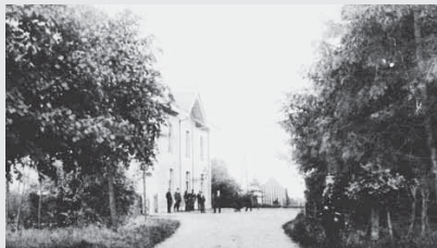
Het stationsgebouw, maar nu van de straatzijde gezien.
