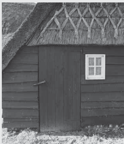
Een ingang van de schuur
