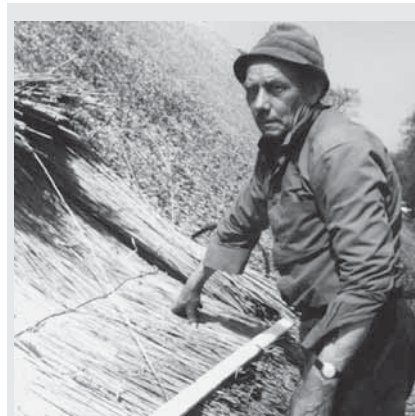
Rietdekker Geert Fokkens van de Hijkerweg uit Beilen aan het werk met het dak.
