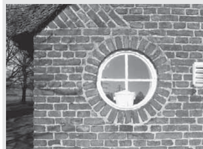
Rond raam in de kopse gevel
