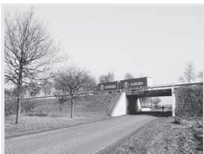
De provinciale weg Emmen-Drachten. Het tracé dat werd gekozen in overleg met de commissie, verdeelt met z'n hoog talud een groot deel van het verkavelde gebied in tweeën. Hier zien we het viaduct Rheevelde.
