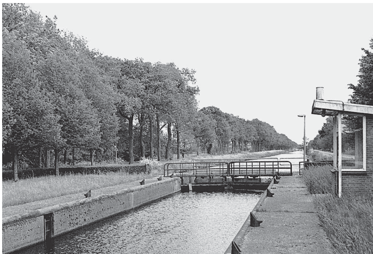
De huidige sluis in het Oranjekanaal schuin tegenover de woning van Jakob de Boer.
