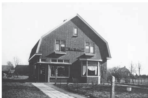
Het pand "De Zon" van Harm Plenter aan de Hoofdstraat. Elslo nam het van Plenter over en bouwde er een smederij achter. Nu is hier garage Siem Schreur.
