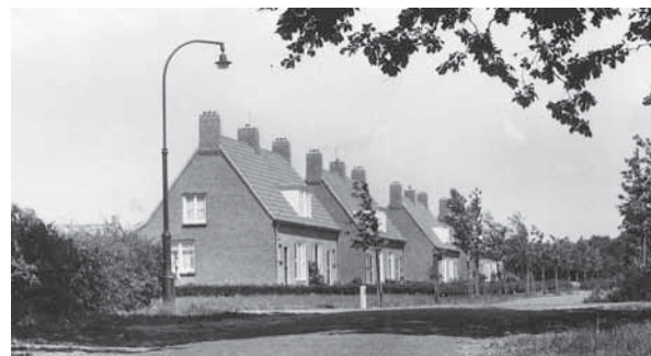
Nieuwbouw aan de Stengelinstraat
