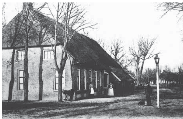
Logement Kuiper, thans Napoleon, gebouwd in 1820, beheerste Hooghalen. De moderne straatverlichting met een petroleumlantaarn staat centraal.
