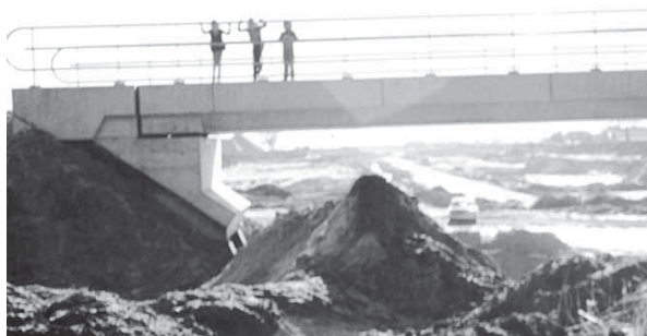
Aanleg van de A28 met het fietsviaduct waarover de wielrijders via de oude Drift van Hooghalen naar Laaghalen en omgekeerd kunnen fietsen.
