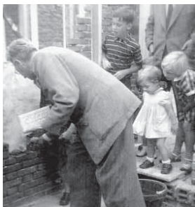
De eerste steen voor het nieuwe huis aan de Esweg wordt gelegd.
