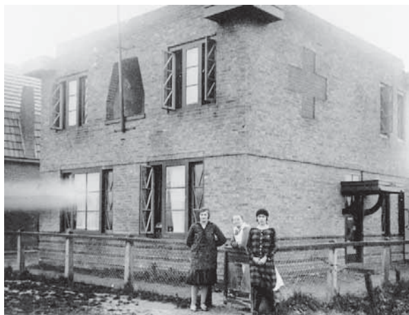
Het Groene Kruisgebouw aan de Brunstingerstraat. Wie goed kijkt, ziet ook nu nog het kruis in het metselwerk van de zijmuur. Het gebouw zelf heeft door verscheidene veranderingen veel van zijn oorspronkelijke uitstraling verloren.
