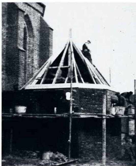
Oktober 1938; de nieuwe aanbouw, de consistoriekamer, wordt gebouwd boven de verwarmingskelder.
