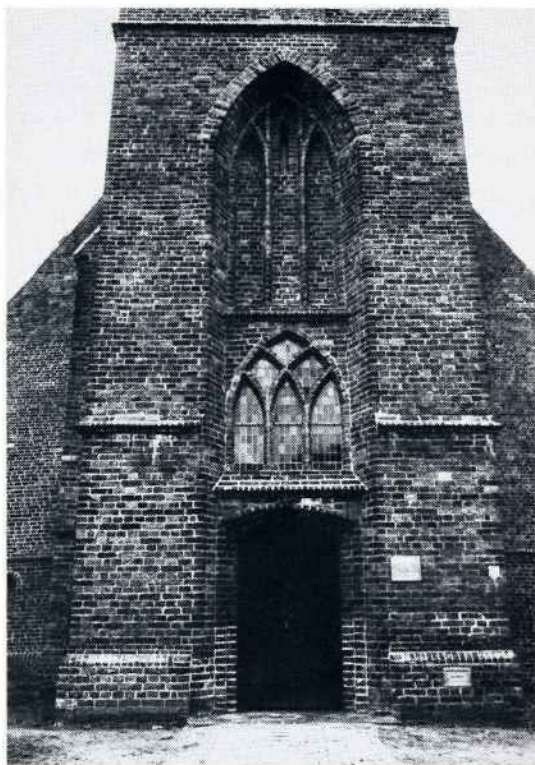
De ingang onder de toren, december 1990. (Foto: Archief Hist. Ver.)
