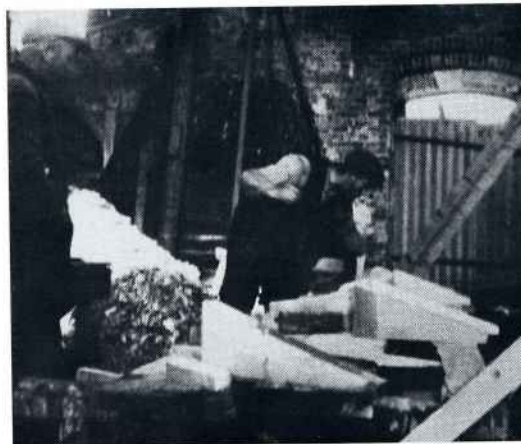
September 1937; het paszagen van de gebogen lijsten voor het tongewelf.
