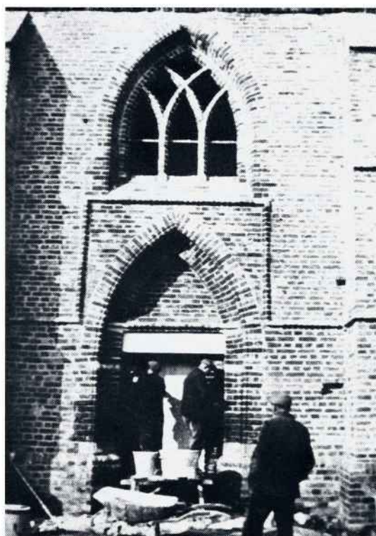
Februari 1938; de laatste hand wordt gelegd aan de ingang in de zuidgevel.
