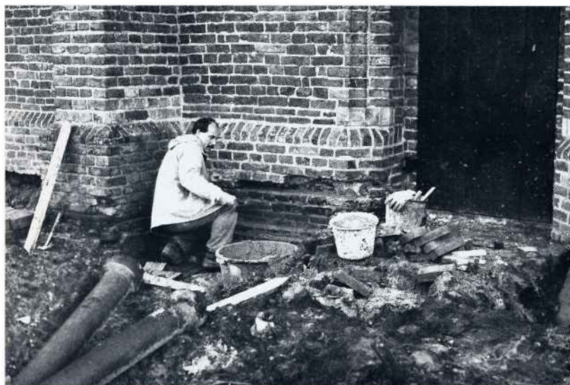
De metselaar werkt de fundering van de buitenmuur af.
