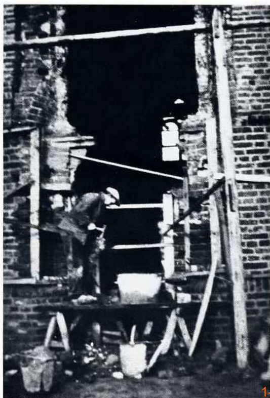
Januari 1938; de monumentale ingang in de zuidgevel is in bewerking genomen.
